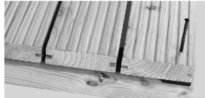
Anfangs-/Abschlussstück als Abstandshalter unter die letzte Diele setzen. Quersteg wiederum nach oben. Abschlussdiele mit Bohrschraube verschrauben.
